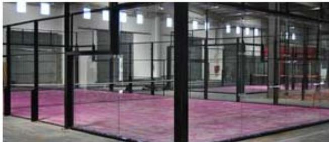
3 renforcements horizontales de 2000( $\pm 5$ )mm en tube de 80x40x2mm (1) ( 2 de fermeture du cadre et 1 destiné à tenir les verres).40x40X2mm,
