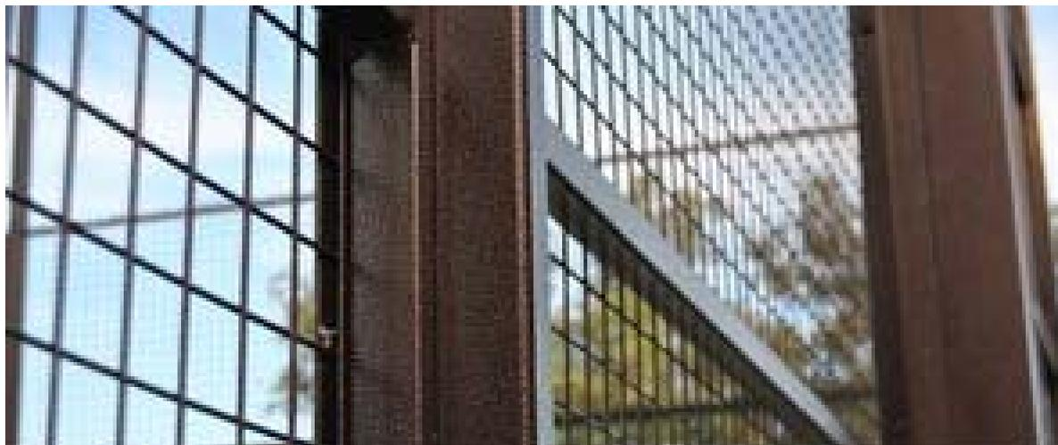
4 renforcement horizontaux de 2000(+5)mm formés en tube 80x40x2mm (2 comme clôture du marc et 2 pour éviter vibrations) 40x20x2mm. 2 panneaux de maille électro soudé 50x50x4mm avec dimensions de 1995x2995 faisant la fermeture du marc.
